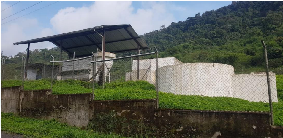
Imagen N° 10 Tanques de agua Linares
